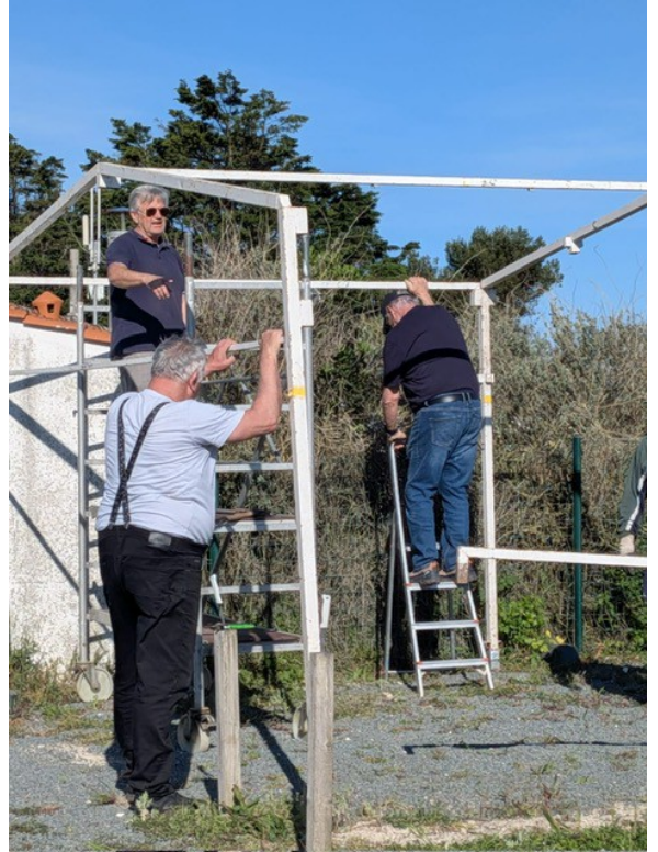
Dernière vérification tout est bon.
